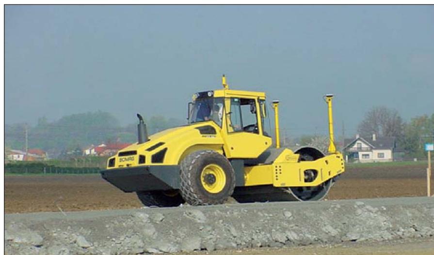
Control de la compactación de toda la superficie asistido por GPS (FDVK) con rodillo autopropulsado y BCM 05 y BCM 05 positioning (posicionamiento)
