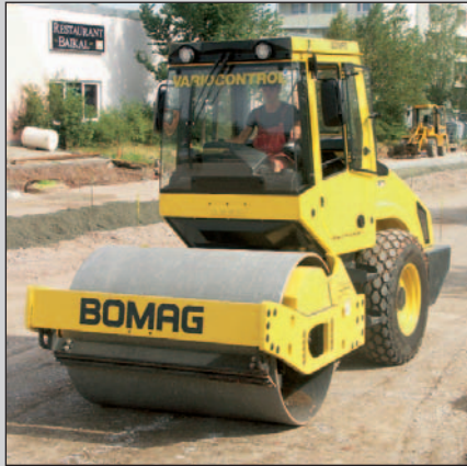
Un BW 177 DH-4 BVC durante la compactación de una capa antihelada en el casco urbano.
