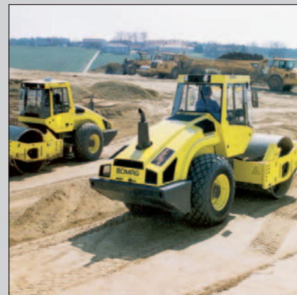
El BW 216 DH-4 para comenzar en el movimiento pesado de tierras.
